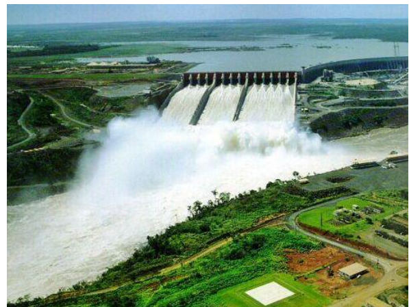
Fotografía 1. Embalse de una central hidroeléctrica
